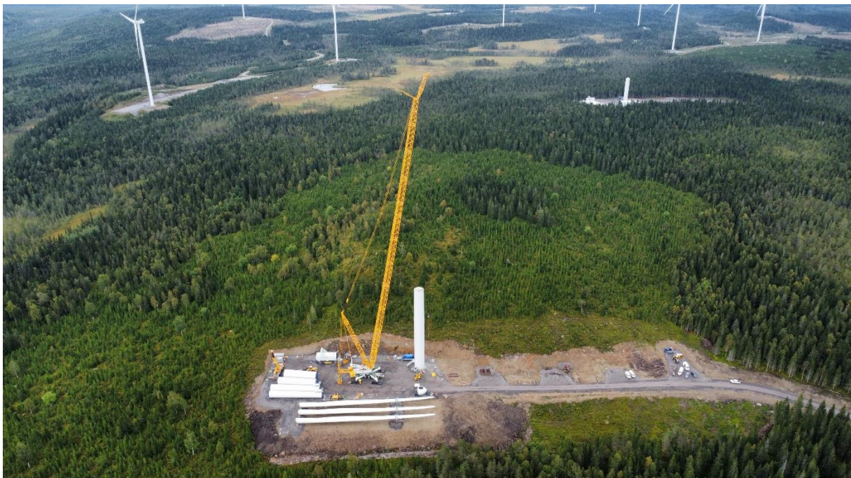
Figur 15. Principskiss och foto på kran- och montageytor © Fred. Olsen Renewables AB
