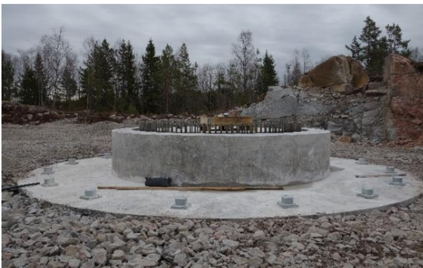
Figur 9. Bergförankrat fundament i en av Fred Olsens vindparker. Foto: Fred. Olsen Renewables AB.
