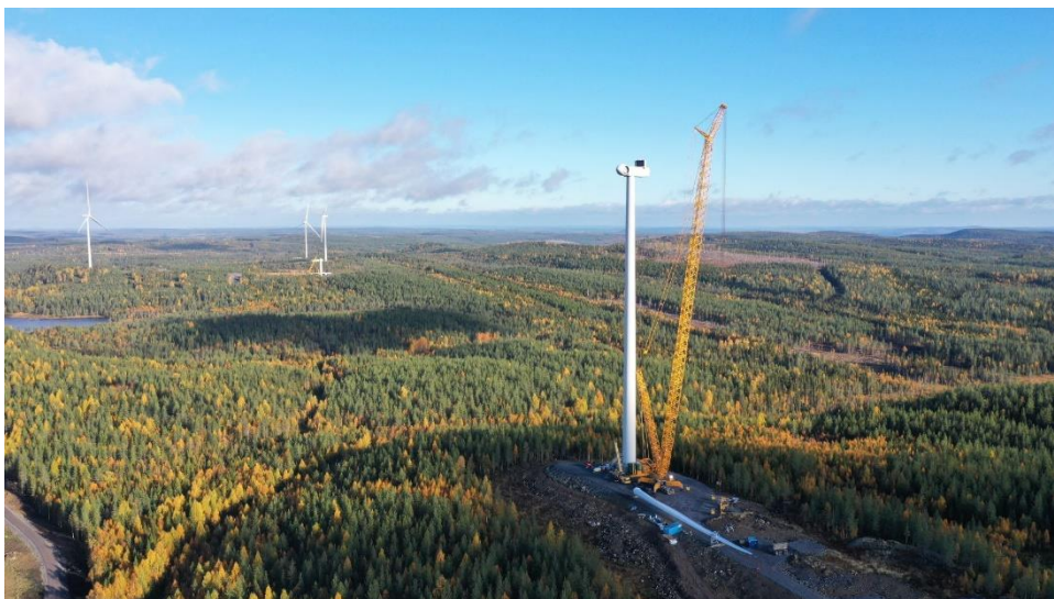
Figur 17. Montering av vindkraftverk. Högaliden Vindpark, Umeå. Foto: Fred. Olsen Renewables AB.
