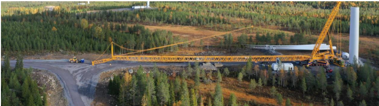
Figur 13. Väg fram till vindkraftverk i en av Fred Olsens vindkraftsparker. Foto: Fred. Olsen Renewables AB.
