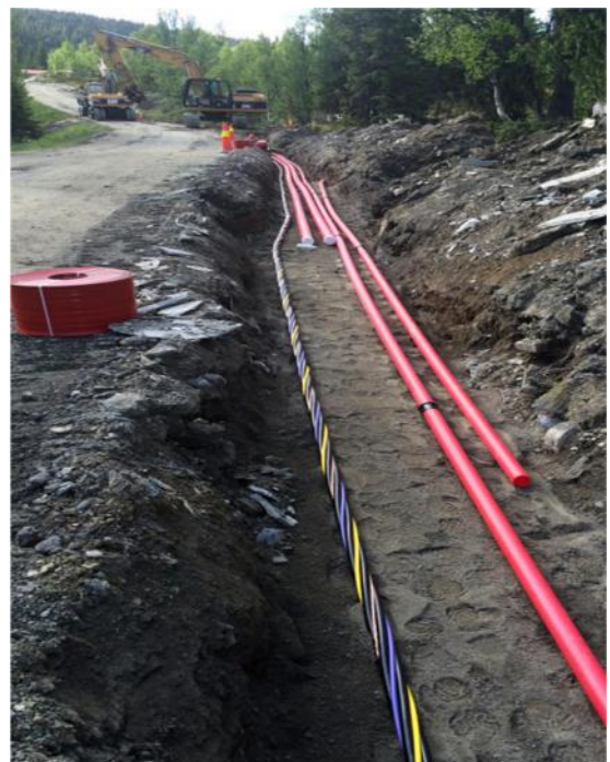
Figur 28 Eksempel på kabelgrøft med trekkerør.
