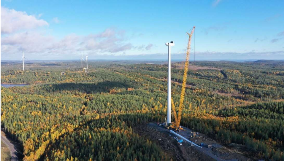
Figur 15. Montering av vindkraftverk. Högaliden Vindpark, Umeå. Foto: Fred. Olsen Renewables AB.
