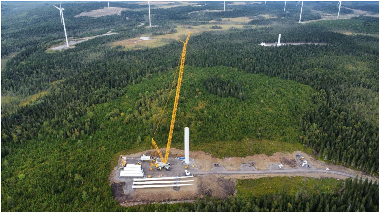
Figur 13. Principskiss och foto på kran- och montageyta © Fred. Olsen Renewables AB
