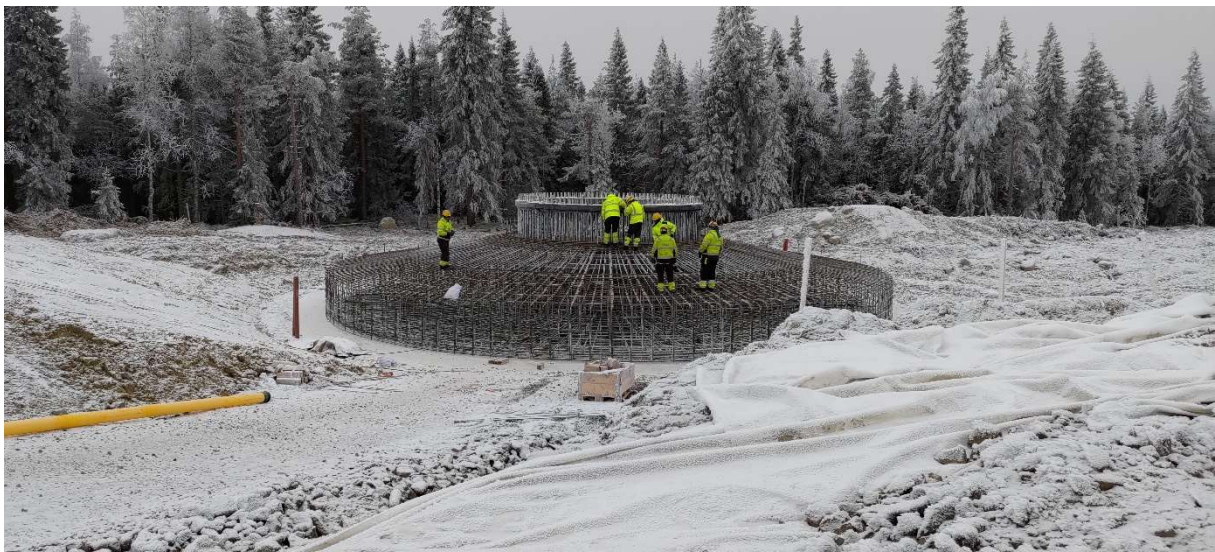
Figur 7. Gravitationsfundament innan gjutning i en av Bolagets vindparker. Foto: Fred. Olsen Renewables AB.
