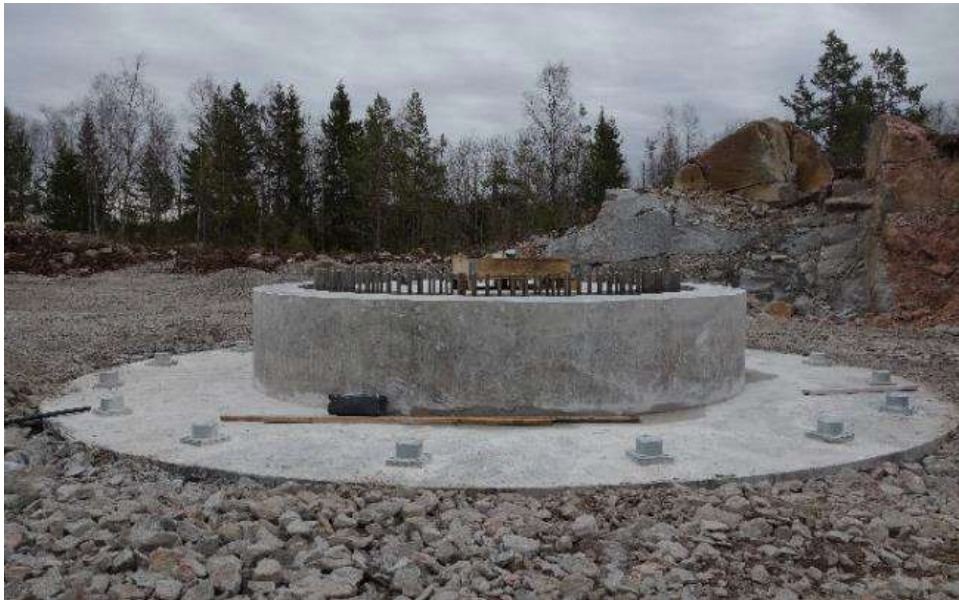
Figur 8. Bergsförankrat fundament i en av Bolagets vindparker. Foto Fred. Olsen Renewables.
